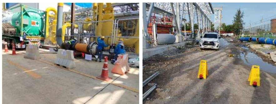
รูปที่ ค-71 กันเขตพื้นที่ก่อสร้าง พร้อมติดป้ายสัญญาณเตือนแสดงเขตหวงห้ามที่อาจเกิดอันตราย
