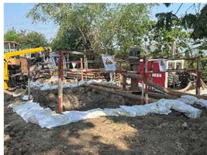
รูปที่ ค-21 โครงการมีการกั้นพื้นที่โดยการจัดวางถุงทรายขณะมีการก่อสร้างบ่อรับ-ปล่อย
