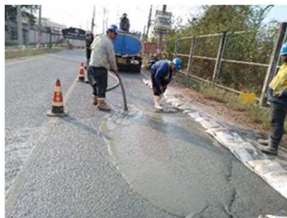
รูปที่ ค-24 โครงการมีการเตรียมรถสำหรับดูดโคลนโซเดียมเบนโทไนท์ กรณีเกิดการรั่วไหล
