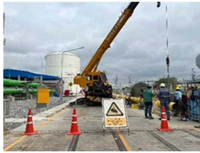
รูปที่ ค-75 กันเขตบริเวณพื้นที่ที่มีการเชื่อมต่อ พร้อมทั้งติดเครื่องหมายเตือนแสดงเขตที่อาจเกิดอันตราย
