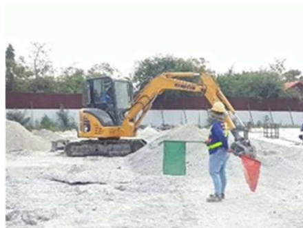
รูปที่ ค-70 กำหนดผู้ทำหน้าที่ขักรวด และขุดอย่างระมัดระวังไม่ให้ถล่มที่อยู่นั้น
