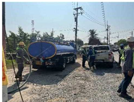
รูปที่ ค-53 ใช้รถดูดในการเก็บเศษดินหรือโคลนโซเดียมเบนโทไนท์ในบ่อรับ-บ่อส่ง
