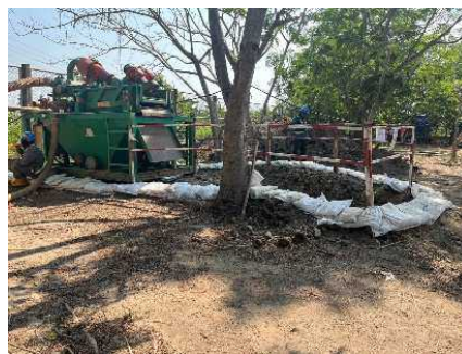
รูปที่ ค-20 โครงการมีการวางถุงทรายหรือจัดทำคันดินกั้นรอบพื้นที่ เพื่อป้องกันการพังทลายของดินลงสู่คลองขุดโก่งกาง
