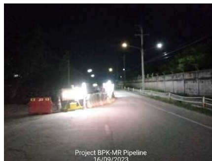
รูปที่ ค-38 กรณีทำงานกลางคืน ต้องติดตั้งไฟสัญญาณกระพริบให้เห็นได้อย่างชัดเจน
