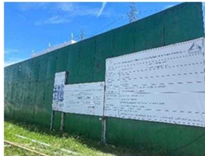
รูปที่ ค-37 ติดตั้งรั้วเหล็ก หรือกำแพงคอนกรีต กันโดยรอบพื้นที่ก่อสร้าง
