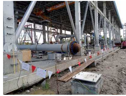
รูปที่ ค-75 กันเขตบริเวณพื้นที่ที่มีการเชื่อมต่อ พร้อมทั้งติดเครื่องหมายเตือนแสดงเขตที่อาจเกิดอันตราย
