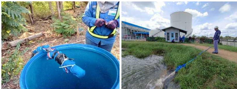
รูปที่ ค-32 ทำการดักตะกอนบริเวณปลายท่อระบายน้ำทิ้ง จากการทดสอบการรั่วไหลของท่อ
