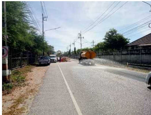
รูปที่ ค-4 ฉีดพรมน้ำบริเวณพื้นที่ที่มีกิจกรรมก่อสร้าง
