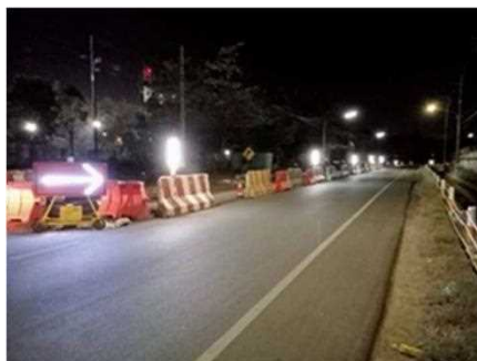
รูปที่ ค-38 กรณีทำงานกลางคืน ต้องติดตั้งไฟสัญญาณกระพริบให้เห็นได้อย่างชัดเจน
