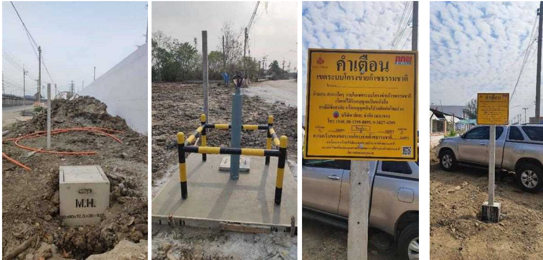
รูปที่ ค-95 โครงการติดตั้งป้ายเตือนและผังผ่านคอนกรีตเหนือแนวท่อเพื่อแสดงให้เห็นว่ามีท่อส่งก๊าซฝังอยู่
