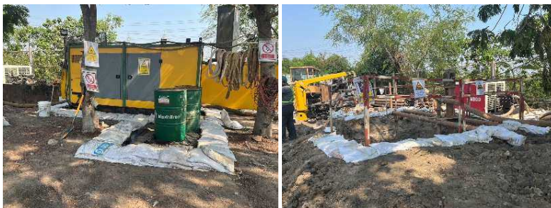
รูปที่ ค-28 จัดวางถุงทรายเพื่อป้องกันโคลนไหลเข้าคลองจากขุดลอกพื้นที่ใกล้เคียง
