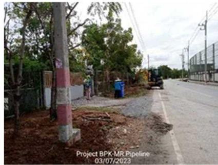
รูปที่ ค-35 ทำทางเบี่ยงชั่วคราว กรณีการวางท่อด้วยวิธีขุดเปิดตัดผ่านทางเข้า-ออกบ้านเรือนชุมชน
