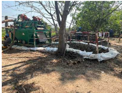
รูปที่ ค-51 จัดวางถุงทรายหรือทำคันดินกันรอบพื้นที่และบริเวณที่มีการหล่นหรือรั่วไหล
