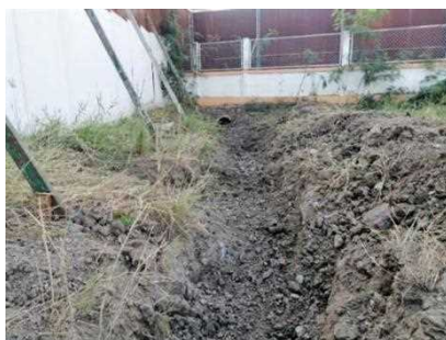
รูปที่ ค-94 ขุดวางระบายน้ำพร้อมเตรียมเครื่องสูบน้ำสำหรับกรณีเกิดน้ำท่วมขัง
