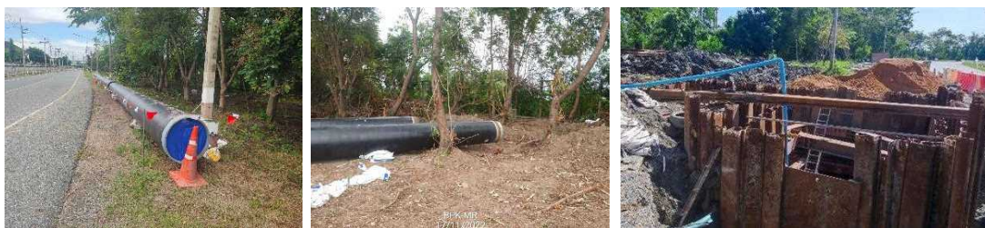
รูปที่ ค-88 จัดทำกำแพงกันบริเวณที่ดำเนินการเชื่อมบรรจุและจัดเก็บท่อเป็นระเบียบอย่างดี
