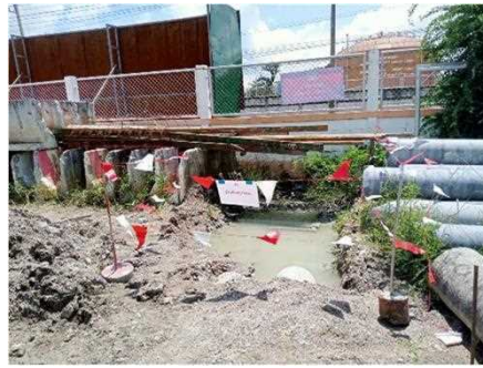
รูปที่ ค-47 โครงการอยู่ระหว่างการก่อสร้างบ่อพักน้ำฝนชั่วคราว
