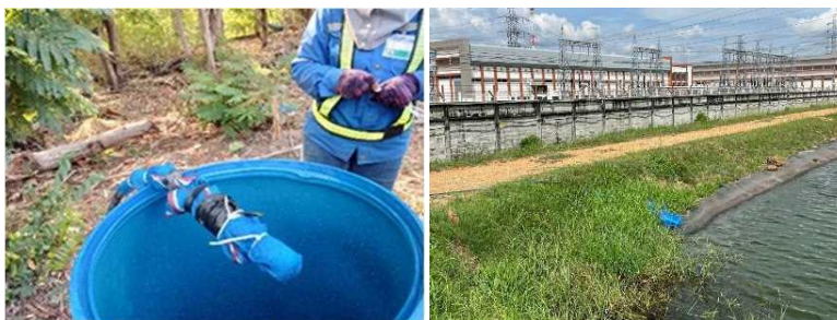
รูปที่ ค-30 ควบคุมอัตราการระบายน้ำออกจากท่าอากาศยาน หลังจากการทดสอบการรั่วไหลของท่อด้วยวิธีทางชลสถิต
